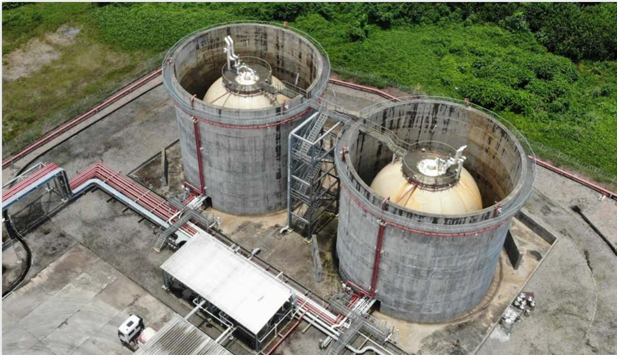
Le Dépôt GPL est une installation opérée par une équipe 100 % SNH, qui a démarré les chargements de camions citernes le 09 avril 2018. Cette infrastructure, qui a une capacité de stockage de 1 000 TM, est approvisionnée par un pipeline à partir des installations de traitement de gaz naturel opérées par Perenco Cameroon. Elle permet de charger des camions citernes ayant une taille moyenne de 20 tonnes métriques.
