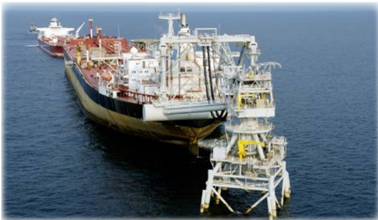
Vue aérienne du KK-1 durant un enlèvement
