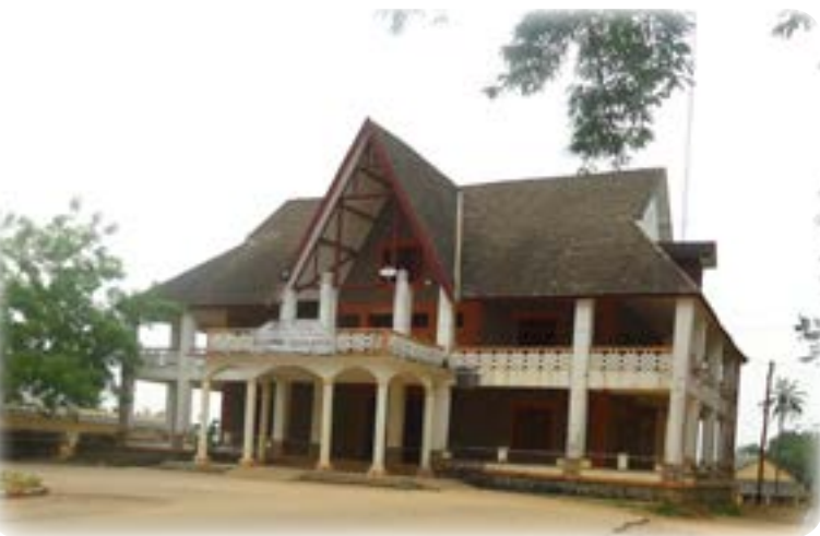
La Préfecture, édifice datant de la période allemande
