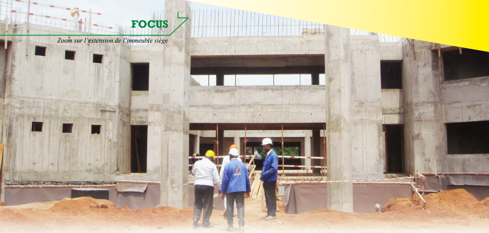
Une vue de l'extension de l'immeuble siège en construction
